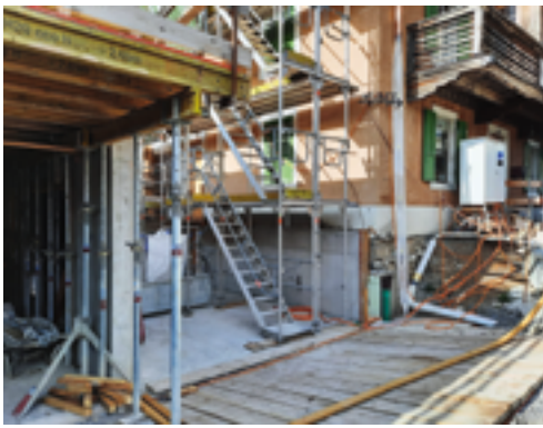
1) L'entrée, entre le nouveau et l'ancien bâtiment, où le public sera accueilli dans un hall confortable. Eingang zwischen dem neuen und dem alten Gebäude mit grosszügiger Empfangshalle für die Besucher.
