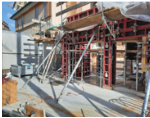
2) Salle en construction sur l'arrière du bâtiment existant. Bau eines neuen Ausstellungsraums an der Rückseite des bestehenden Gebäudes.
